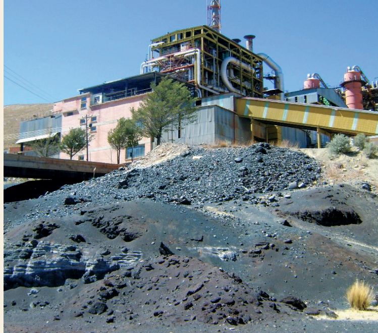
La Palca antes de la intervención
