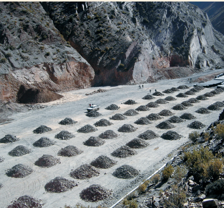
Trabajos realizados en Tasna (antes)
