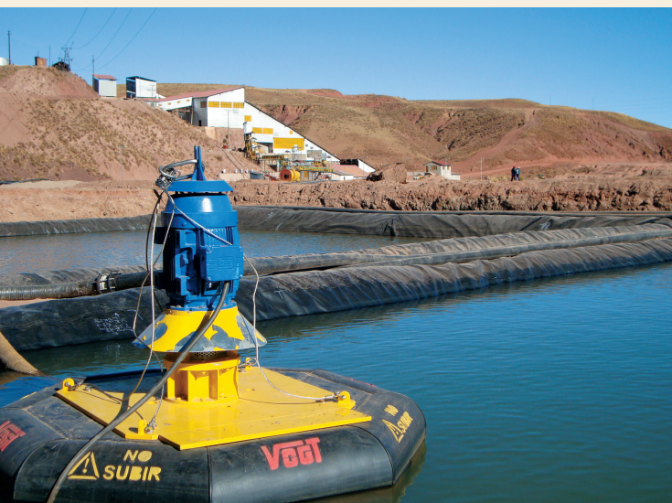
Piscinas de lixiviación y planta hidrometalúrgica de Corocoro.
