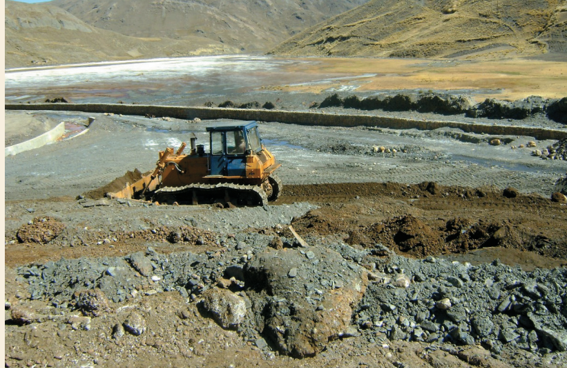
Movimiento de tierras en Mina Matilde.
