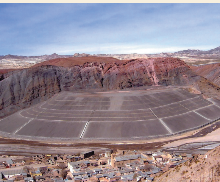
Dique de colas Telamayu - después del proceso de cierre ambiental.
