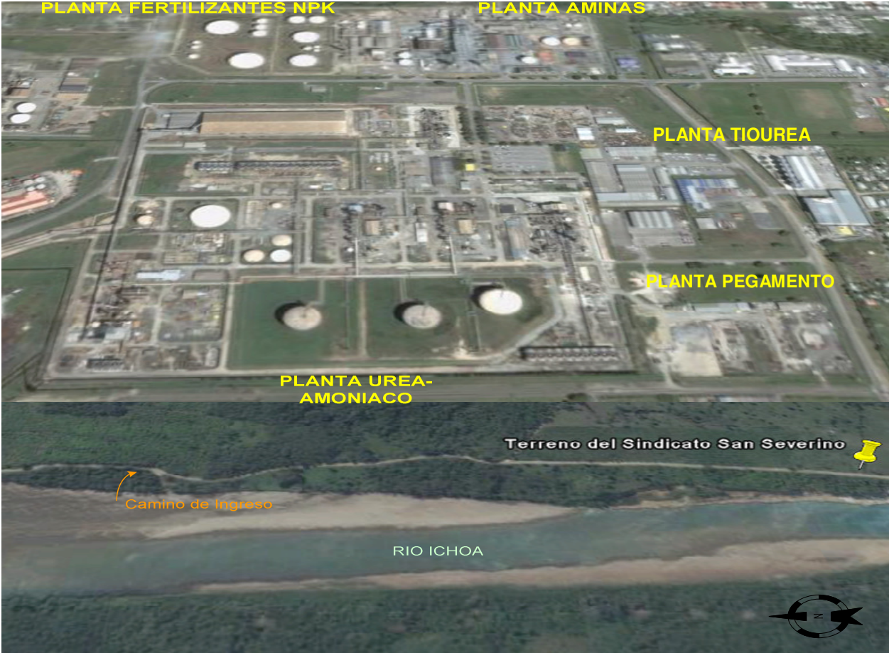
Figura 1. Complejo Petroquímico en Carrasco Tropical - Cochabamba
