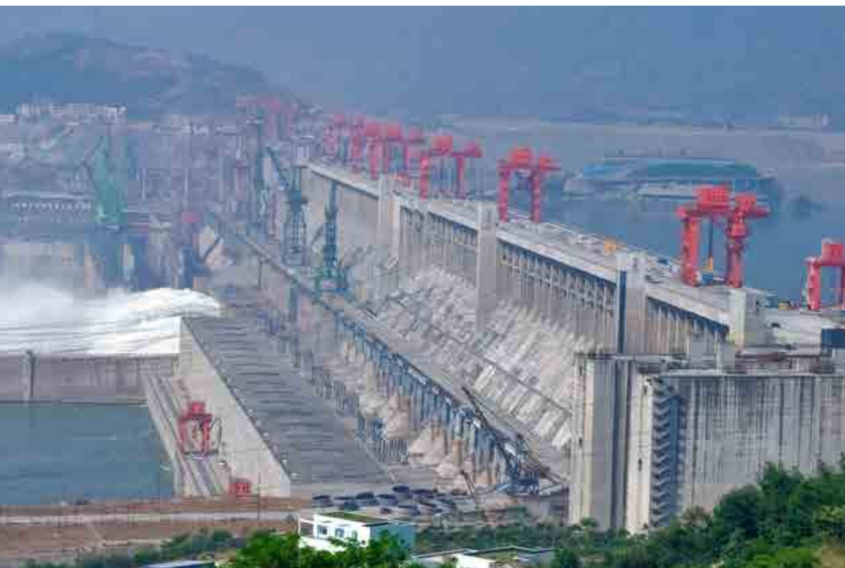
Construcción de la Represa Las Tres Gargantas. Muchas compañías hidroenergéticas chinas en el exterior han desarrollado su experiencia en China con proyectos de megarepresas como la Represa Las Tres Gargantas. Foto: Chris De Bode/Panos.
