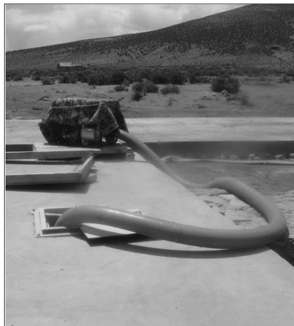
La empresa abastece de agua a San Cristóbal y Culpina K a través de estos ojos de agua. Con el tiempo, existe el riesgo de que el agua se acabe por la gran cantidad que usará la empresa en la mina.
