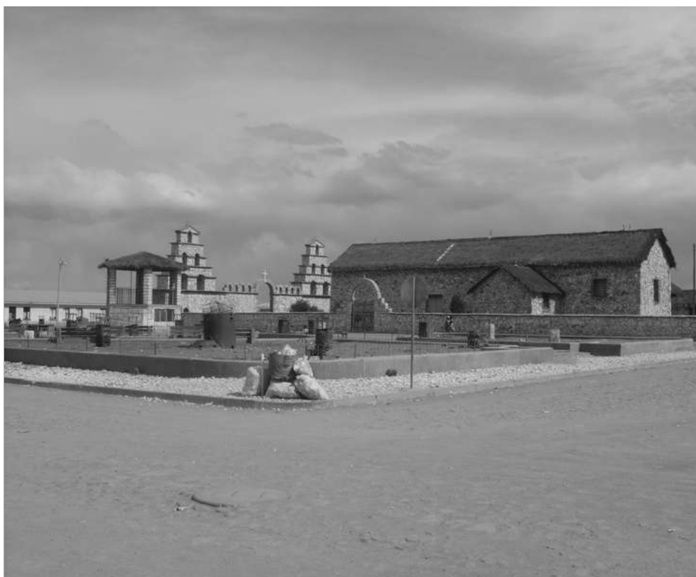
La plaza principal del nuevo pueblo de San Cristóbal donde se trasladó, piedra por piedra, el templo construido a finales del siglo XVII.
